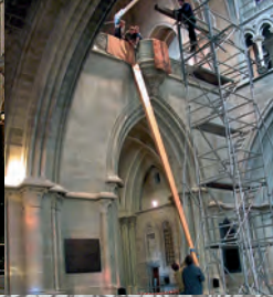
Abbau der 32' Zunge
